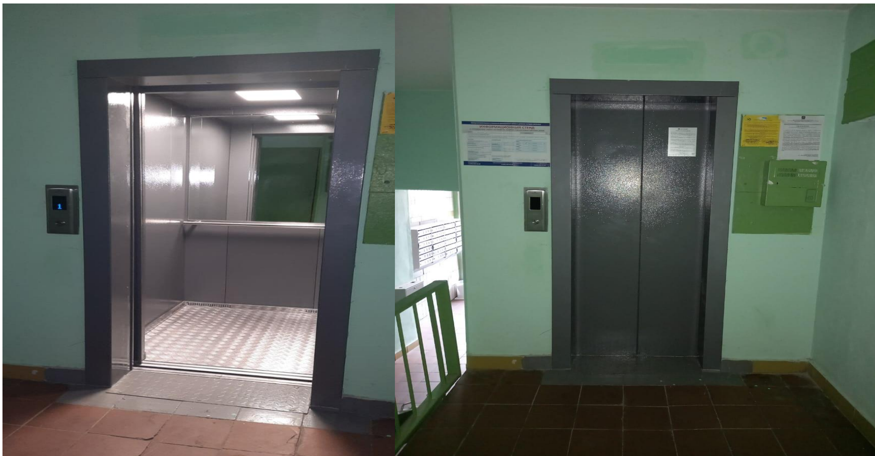
ул. Салтыковская, д. 7, корп. 3, под.3
