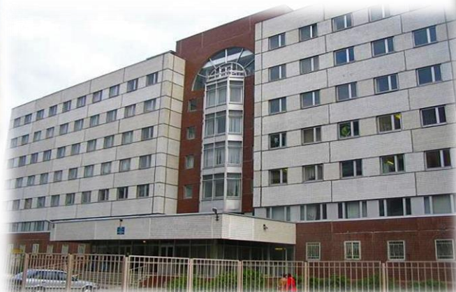
Основной корпус (ранее «ГП №66») ул. Салтыковская, 116.
